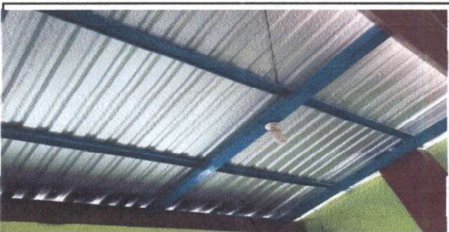
Foto 5: COLOCACIÓN DE LÁMINA TROQUELADA CON ESTRUCTURA METÁLICA DE LA COCINA
