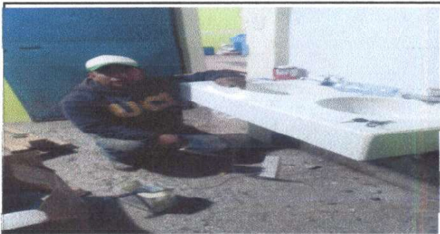
Foto 3: INSTALACIÓN DE LAVAMANOS
