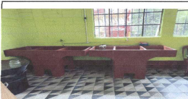
Foto 6: COLOCACIÓN DE PISO CERÁMICO Y PILAS DE LA COCINA ESCOLAR
