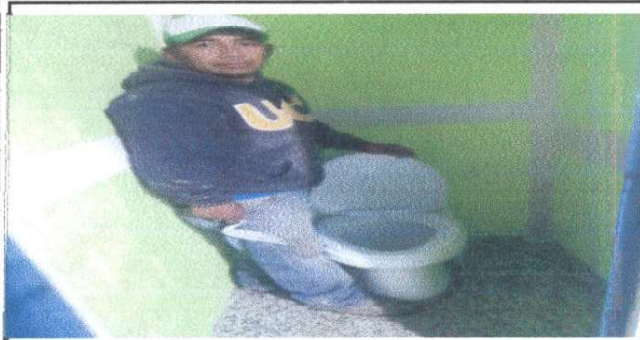
Foto 1: INSTALACIÓN DE TAZA DE SANITARIOS
