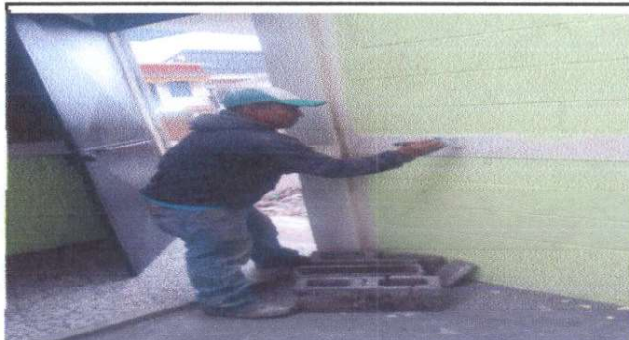
Foto 4: PINTURA DE MUROS INTERIOR Y EXTERIOR
